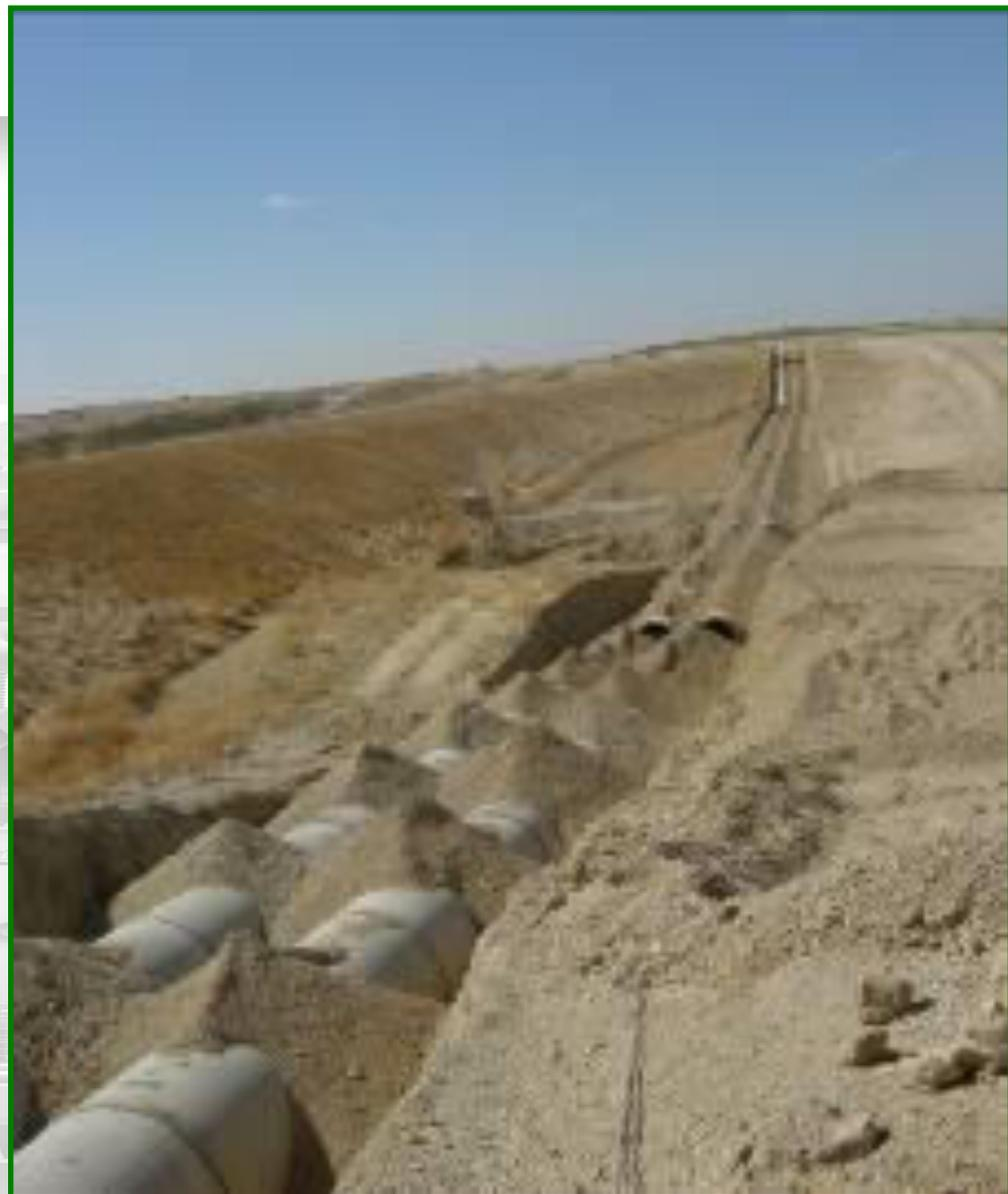
Tener las juntas descubiertas si supone algún riesgo de seguridad o de flotabilidad es conveniente el tapado completo. Esto puede ocurrir en zonas donde el trazado de la tubería transcurre por lugares cercanos a una carretera, camino, ríos, arroyos, nivel freático alto y se puede producir algún accidente.
