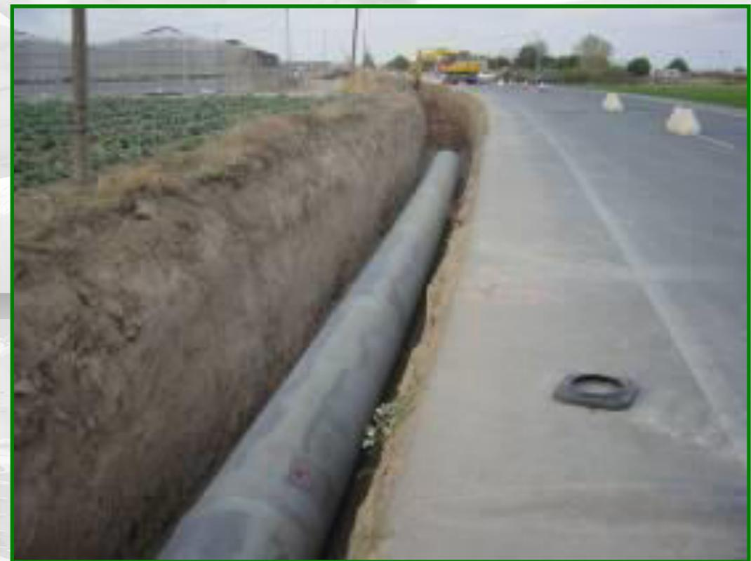
La tubería de hormigón con camisa de chapa tiene dos tipos de junta: **soldada y elástica.**
