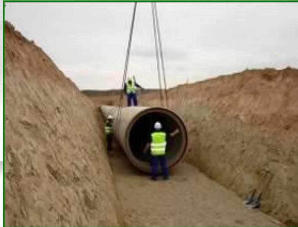
**“Tubería de PRFV”** (tubería flexible)
