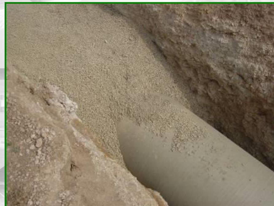
**Es importante cumplir fielmente el tapado y el relleno de la tubería conforme a las recomendaciones del proyecto y del fabricante. Ya que el funcionamiento de la tubería depende de la cama de asiento, un buen arriñonamiento y un correcto tapado. En conducciones correctamente montadas es muy improbable que existan fugas. No es así cuando la tubería no está bien instalada, aparecen blandones, punzonamientos por piedras de gran tamaño, aplastamientos, malos apoyos del tubo, etc.**
